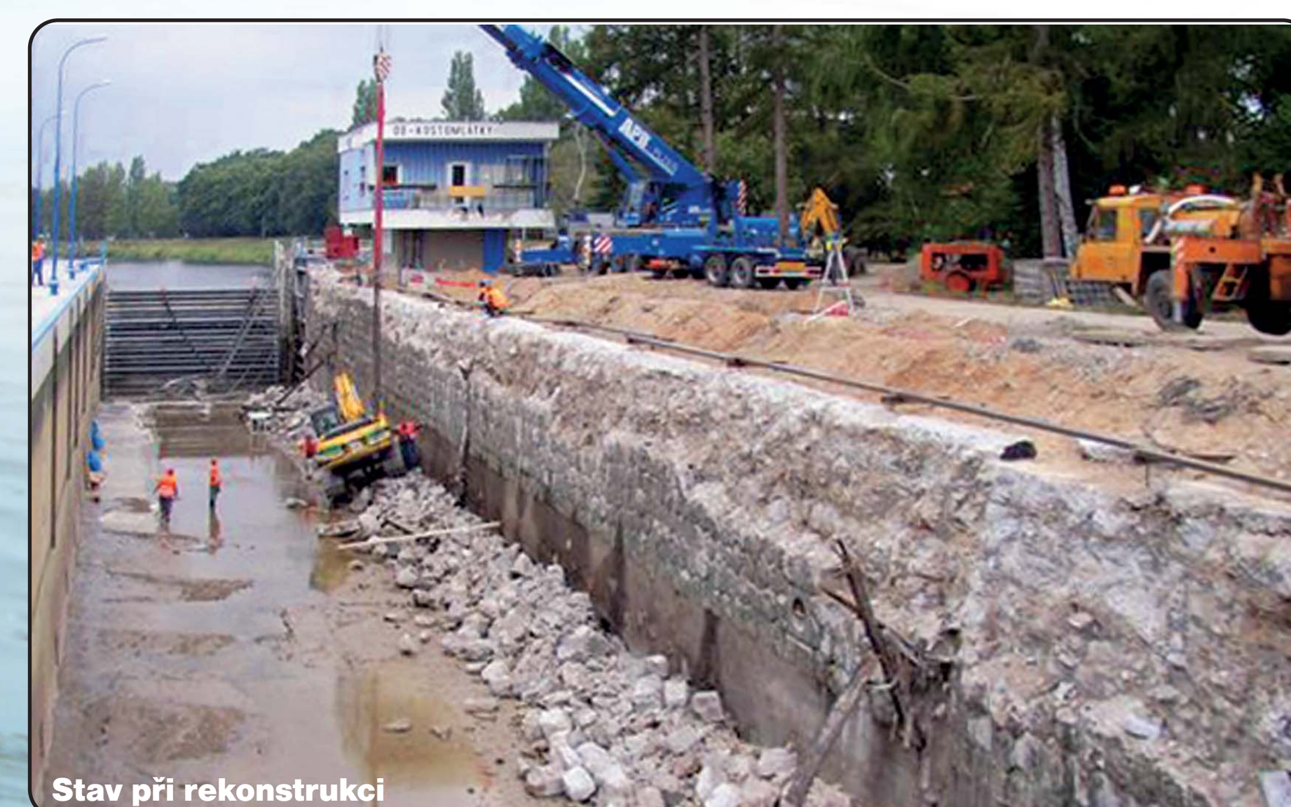
Stav při rekonstrukci
