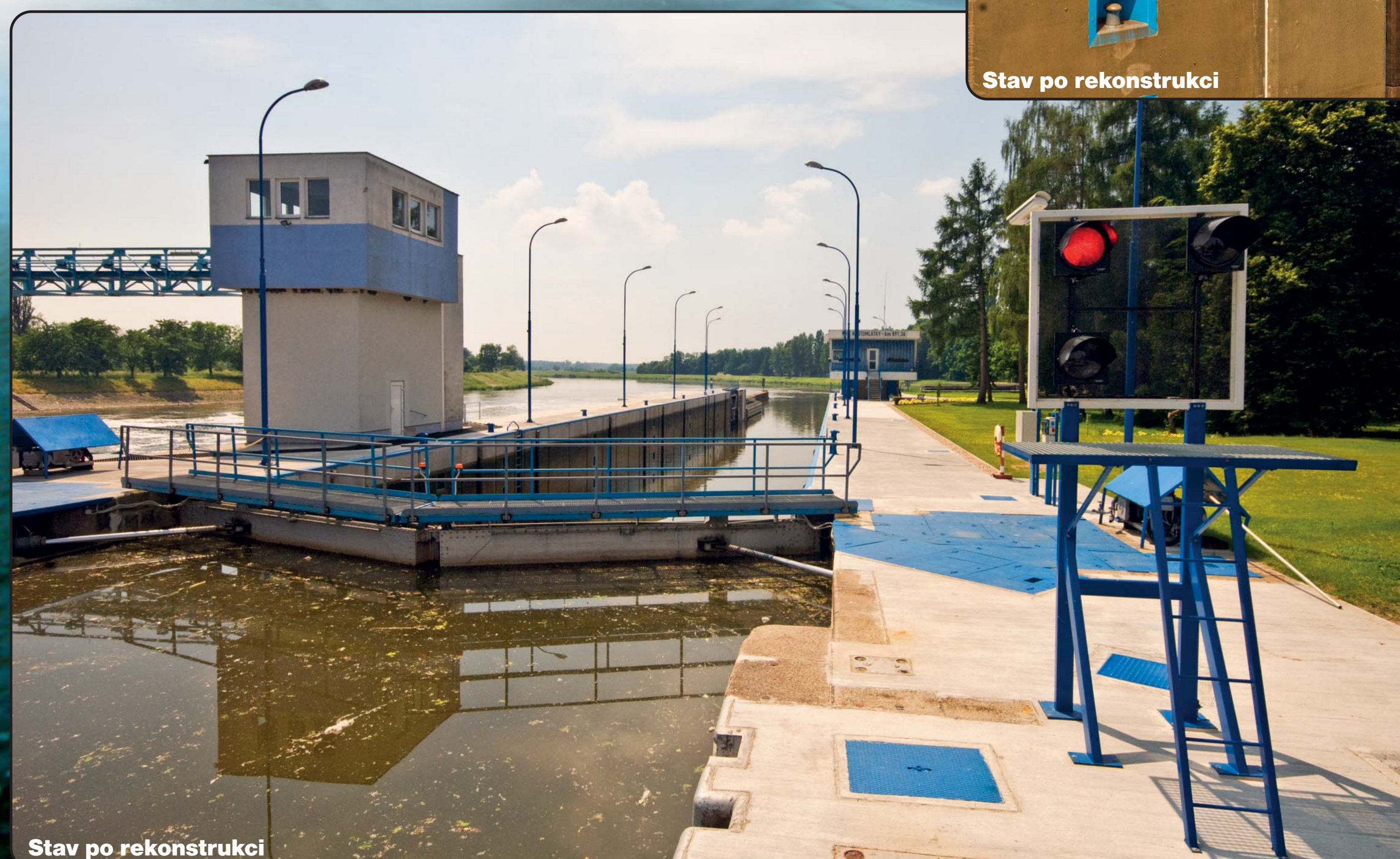
Stav po rekonstrukci
