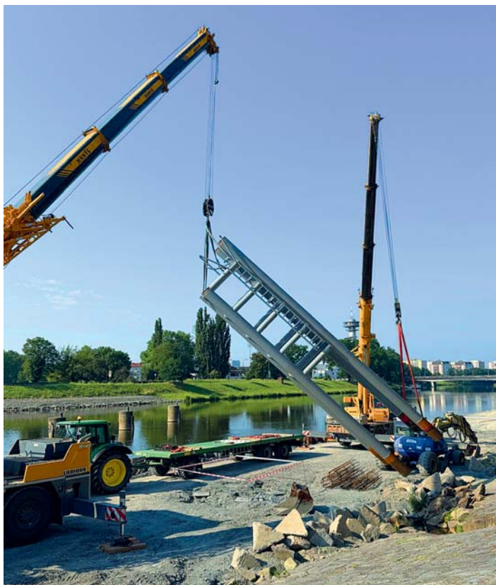
V Pardubicích v současnosti vzniká ochranné stání u plavební komory
