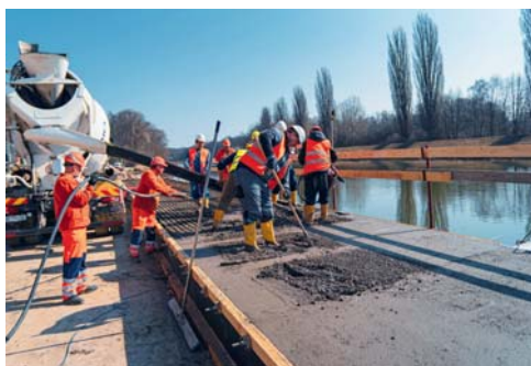
Betonáž železobetonové pochozí desky přístaviště
