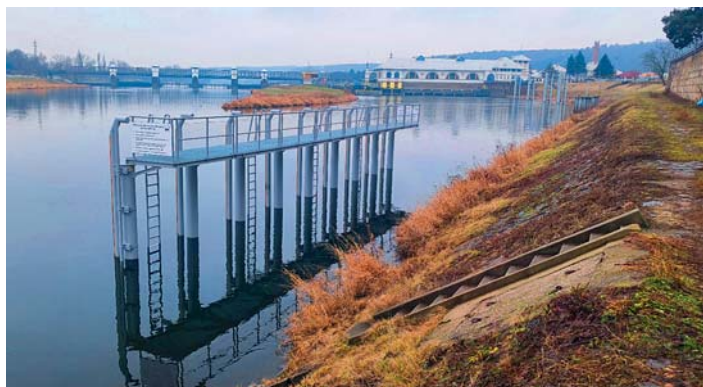
Nové čekací stání v horní a dolní vodě plavební komory Měřejovice
