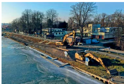
Práce na zarážení štětovic pokračovaly i v silných mrazech kolem -15 °C
