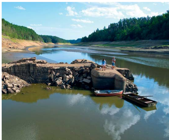
Pod Podolským mostem jsou hojně navštěvované z základy původního řetězového mostu
