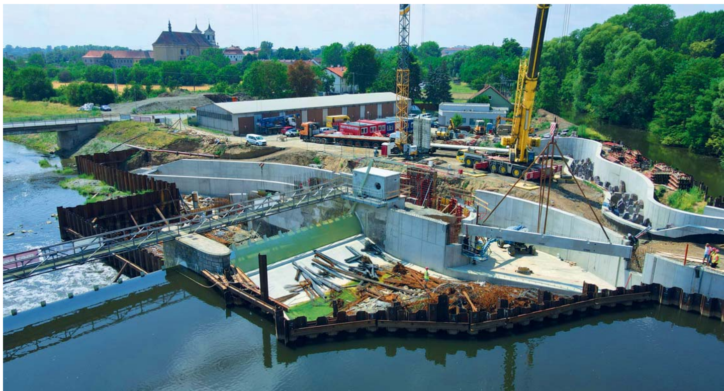
Montáž prefabrikované lávky nad vtokem do MVE (v pozadí Benediktinský klášter v Rajhradě s památníkem písemnictví)
