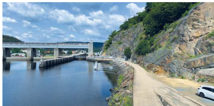
Nové čekací stání v horní vodě plavební komory Štěchovice
