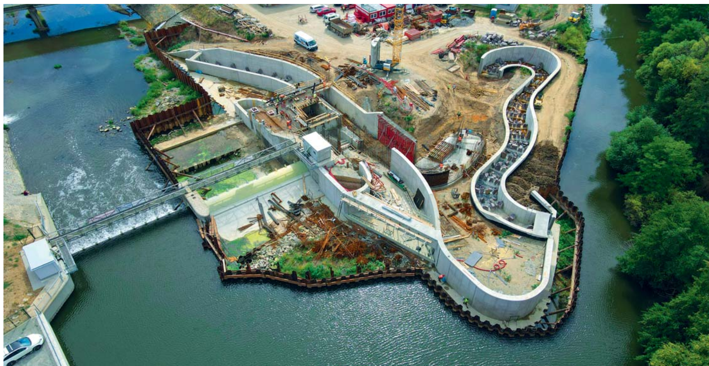
Pohled na celou stavbu z ptáčí perspektivy (zleva – zrekonstruované levé pole jezu na Svratce, zajímavé pravé pole, rozestavěná MVE, rozestavěný rybí přechod, náhon)
