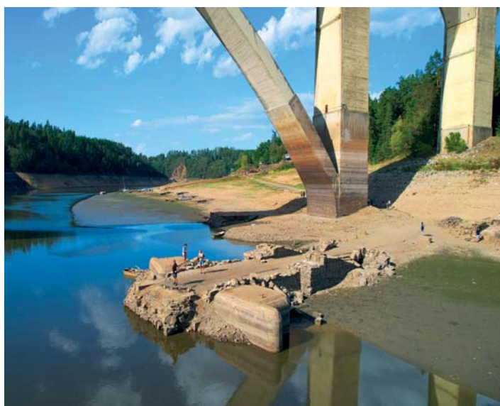
Současná rekordně nízká hladina VD ORLÍK odhaluje mnohé zatopené stavby a bunkry
