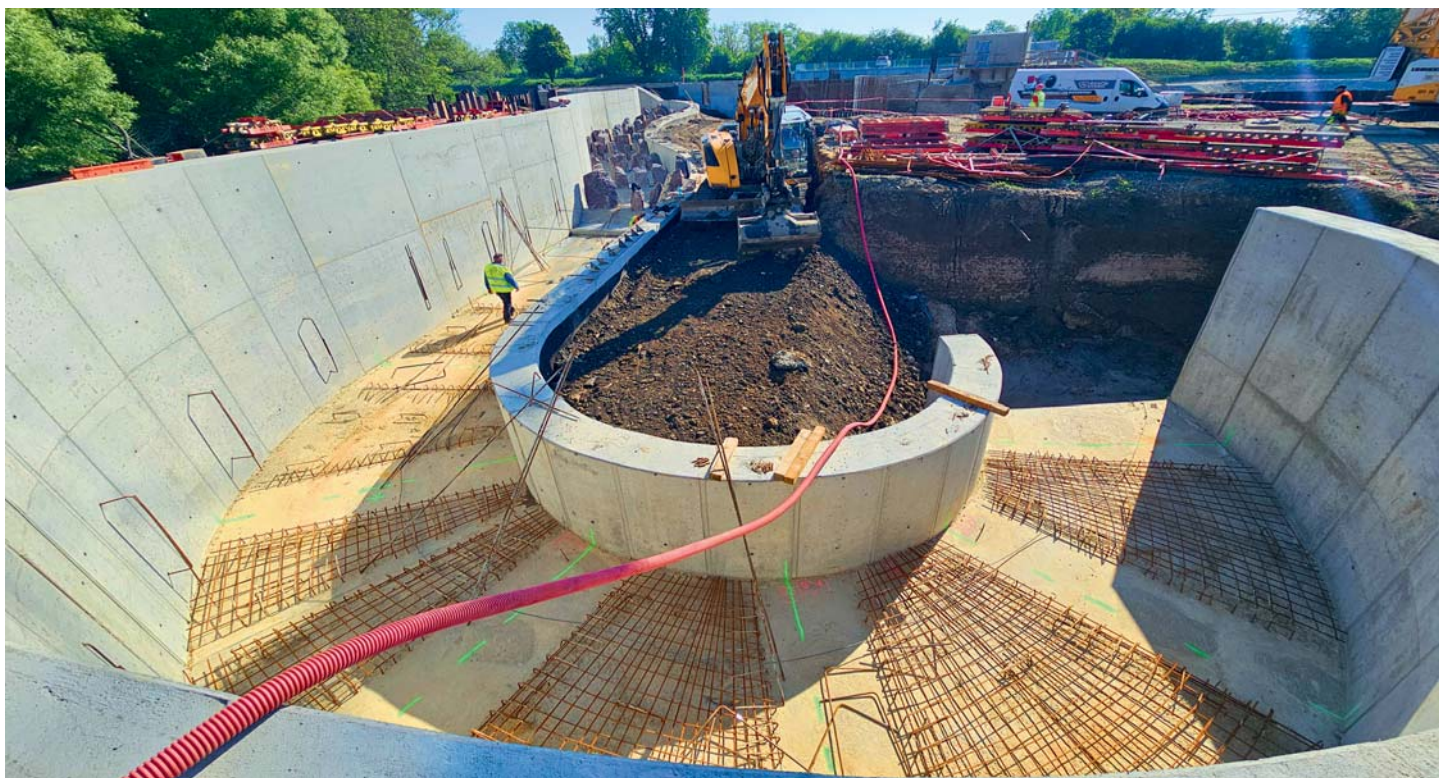
Pohled do ohybu rybího přechodu s přípravou na osazení kamenných přepážek
