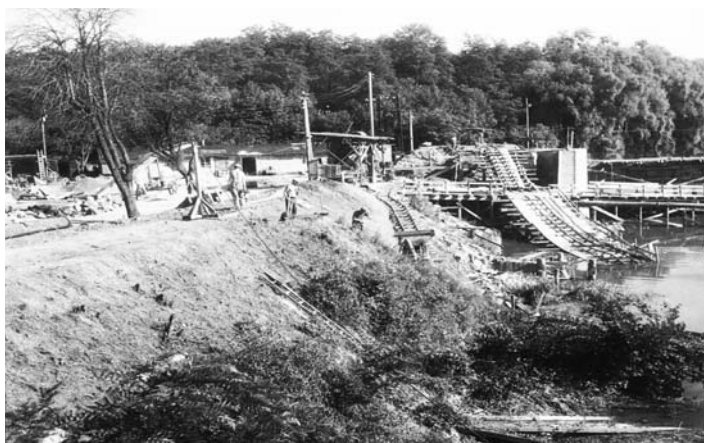
Jez na Svatce u Rajhradu, úprava břehu, svaznice pro odkop a rovnání pravobřežního svahu (foto z výstavby v letech 1948-1954)
