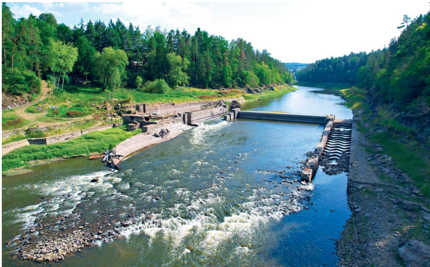
Letošní přítoky vodního díla Orlík jsou na extrémně nízké úrovni. Pokles hladiny odhalil stavby běžně skryté pod vodou jako zbytky Novomlýnského jezu
