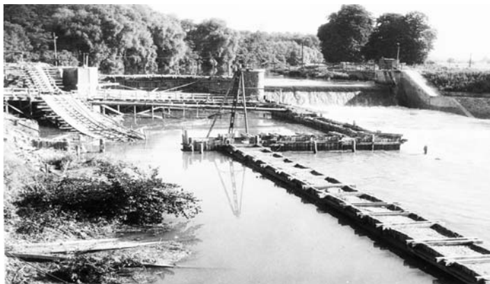
Jez na Svatce u Rajhradu, celkový pohled na jez se zatopenou stavební jámou od silničního mostu (foto z výstavby v letech 1948-1954)
