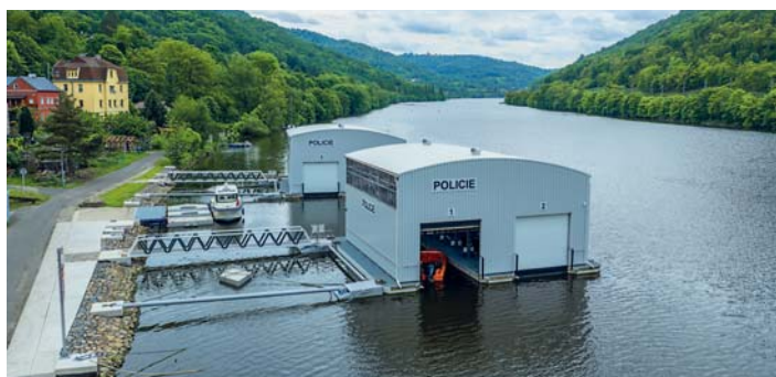
Nová krytá stání pro služební plavidla v Ústí nad Labem - Brná
