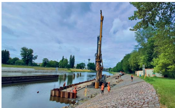
Nové ochranné stání v dolní rejdě plavební komory Pardubice - realizace
