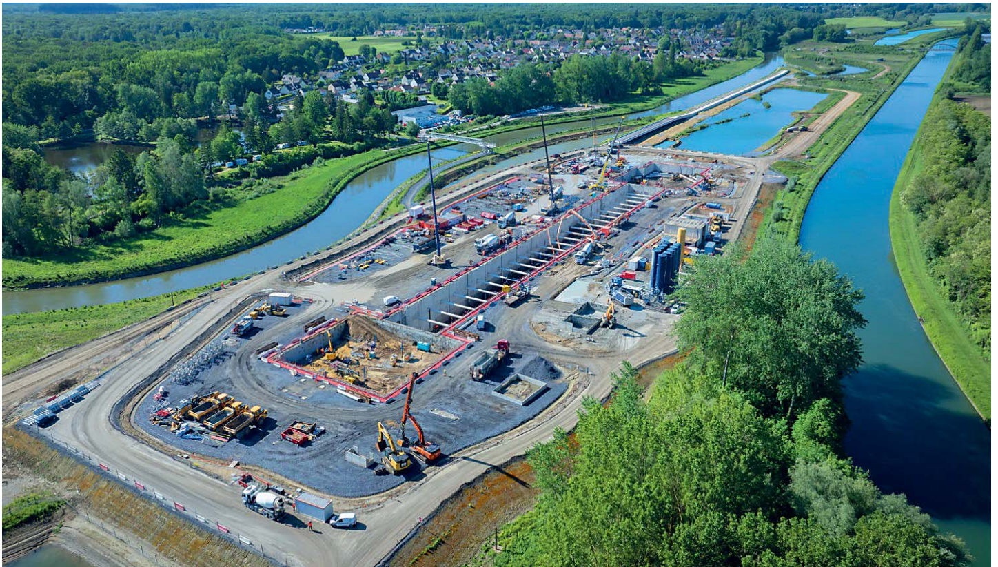
Stavba průplavu Seina-sever ve Francii již běží naplno – staveniště plavební komory Montmacq
