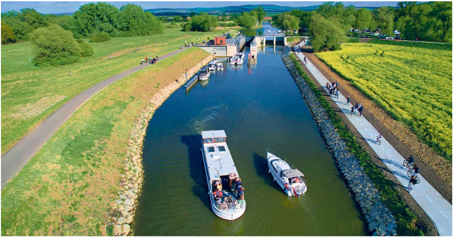
Pohled na plavební komoru Rohatec – Sudoměřice z dolní vody
