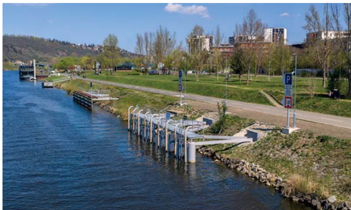
Nové čekací stání pro malá plavidla v dolní rejdě plavební komory Praha-Modřany
