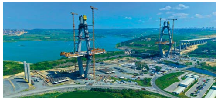
Stavba dálničního mostu přes budoucí Istanbulský průplav
