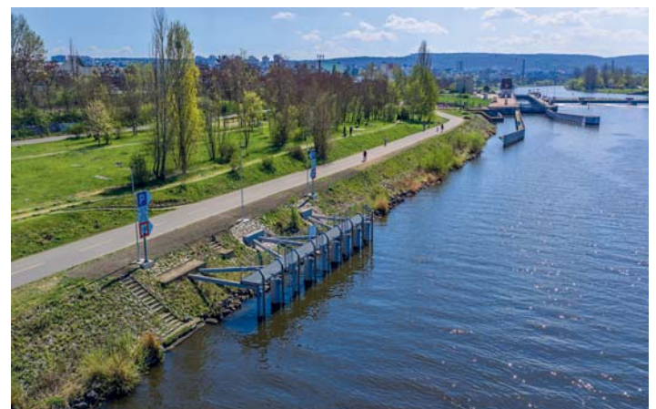
Nové čekací stání pro malá plavidla v dolní rejdě plavební komory Praha-Modřany
