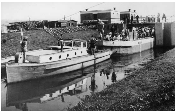
Baťův kanál byl využíván nejen pro přepravu nákladů, ale také pro rekreaci obyvatel prakticky hned od svého otevření
