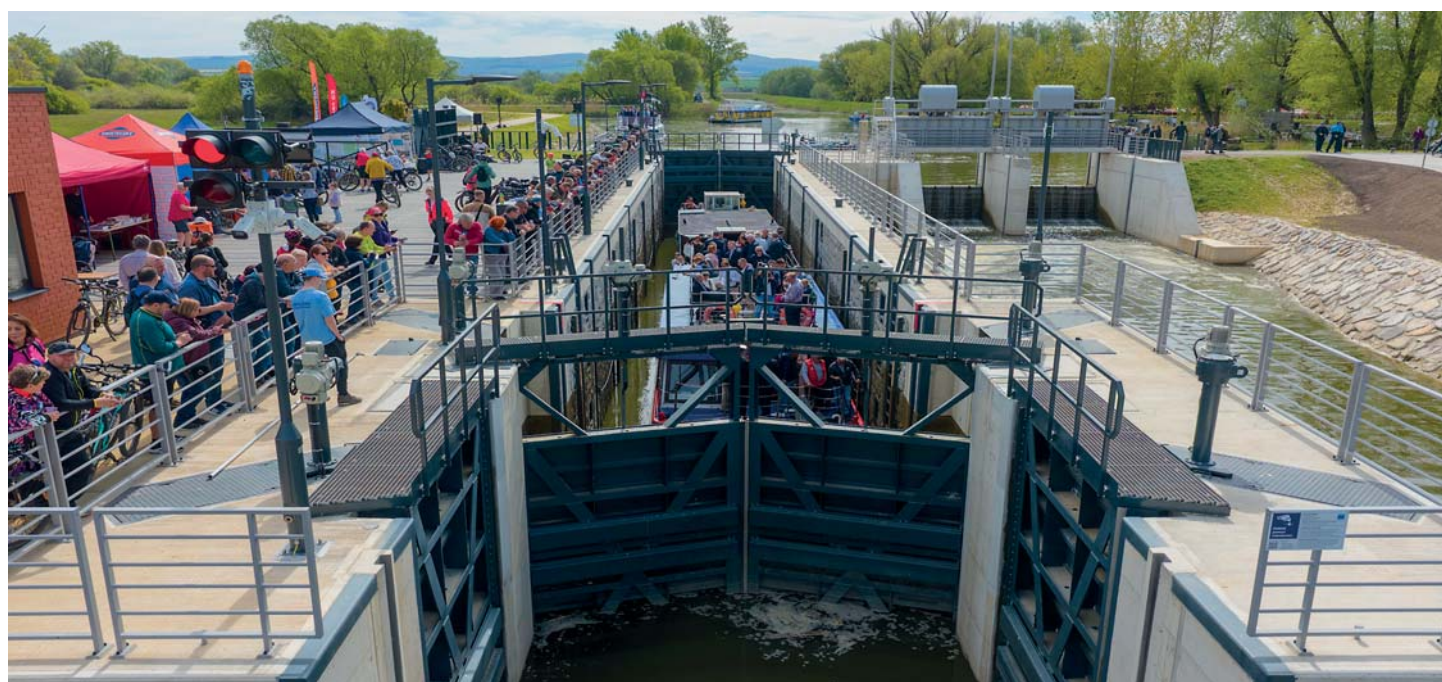
Plavební komora Rohatec – Sudoměřice
