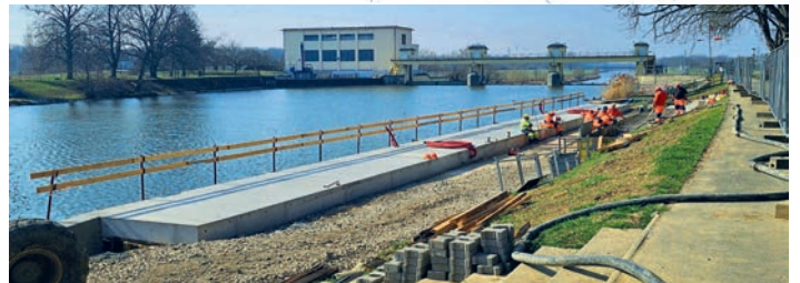
Stavba rozšíření přístaviště na řece Moravě v Hodoníně
