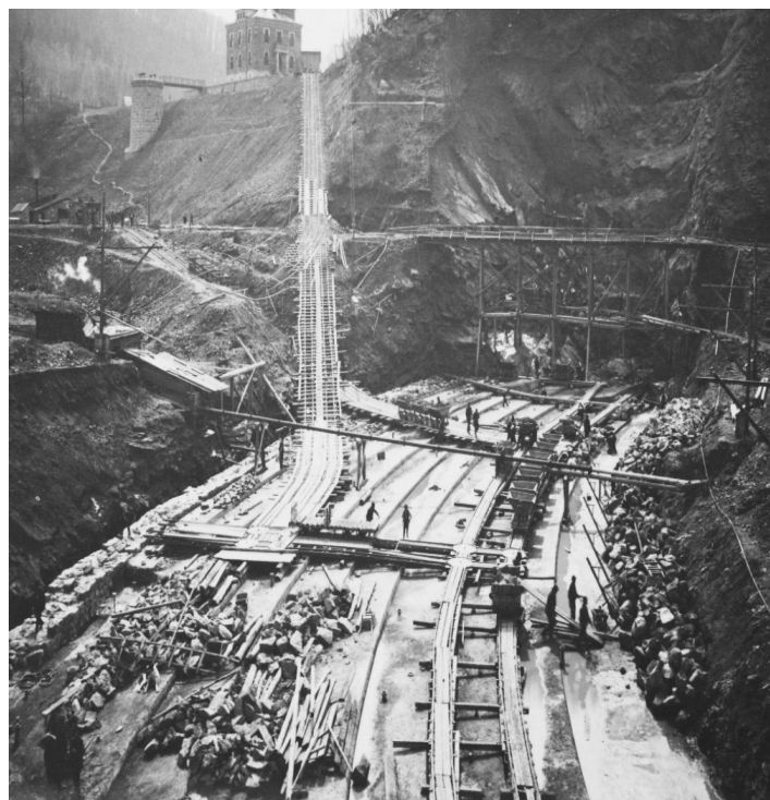
Přehrada Bystřička je jedním z mála dokončených staveb průplavu Dunajsko-oderského
