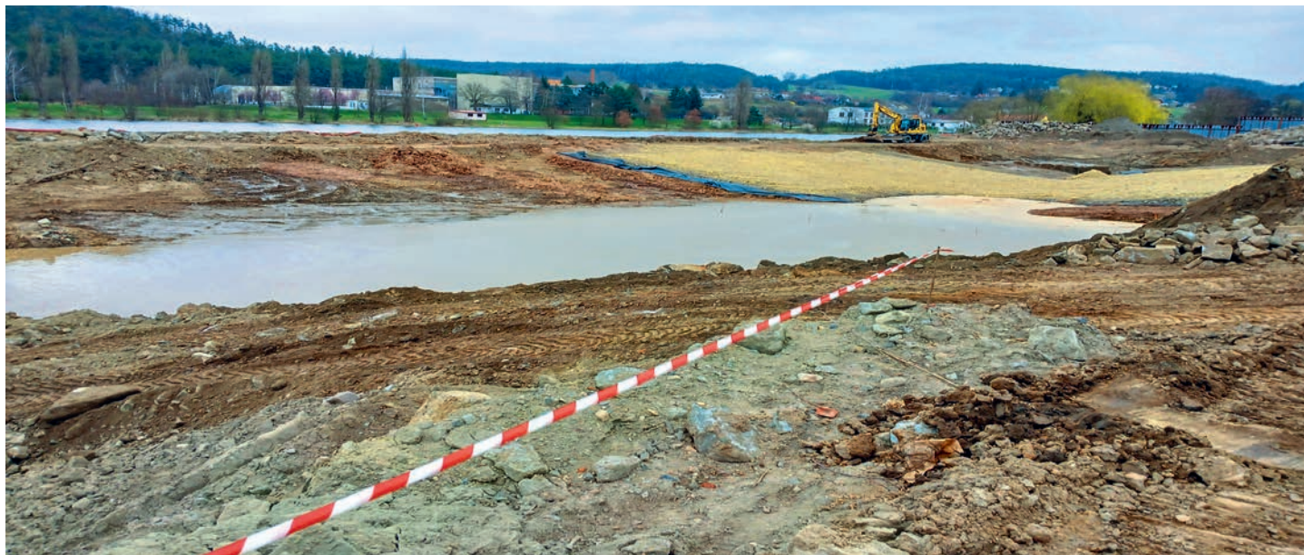
Realizace jílového těsnění a vrchní vrstvy říčních oblázků slepého říčního ramene (duben 2025)
