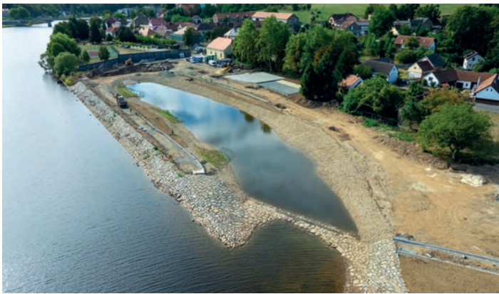
Provádění přístupových cest (srpen 2025)
