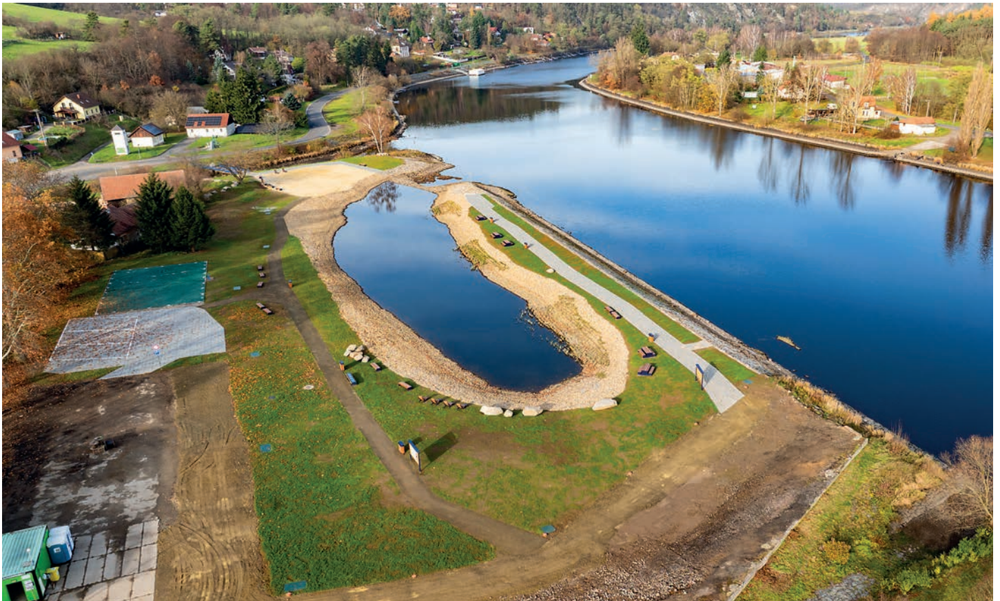
Pohled na povodňový park Kamýk nad Vltavou (listopad 2025)
