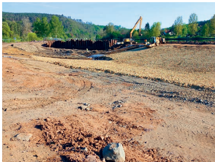
Pohled na ústí slepého ramene a přelévavý dnový práh (duben 2025)
