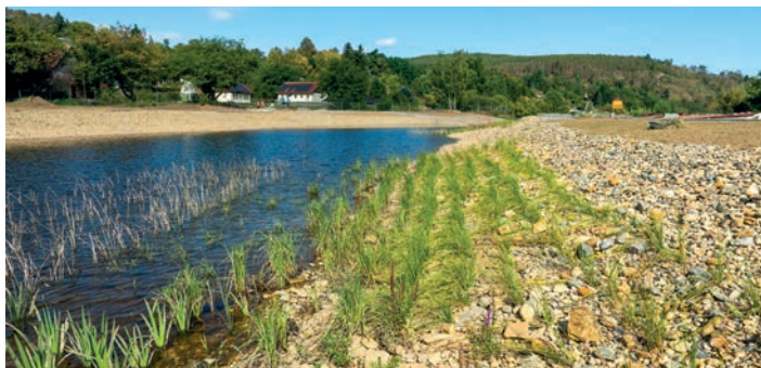
Pohled na pravý břeh slepého říčního ramene (listopad 2025)
