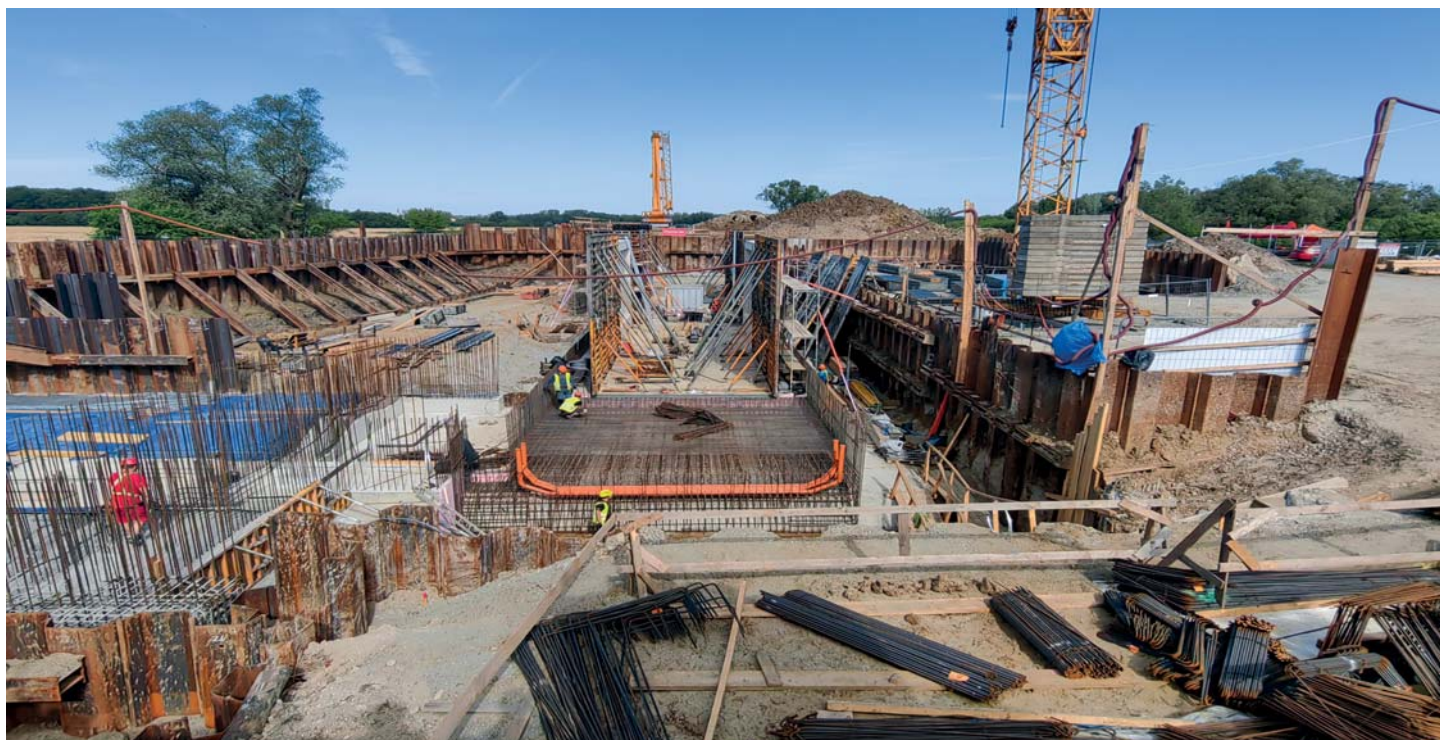
Armování základů a stěn PK Rohatec – Sudoměřice – 1. května 2024
