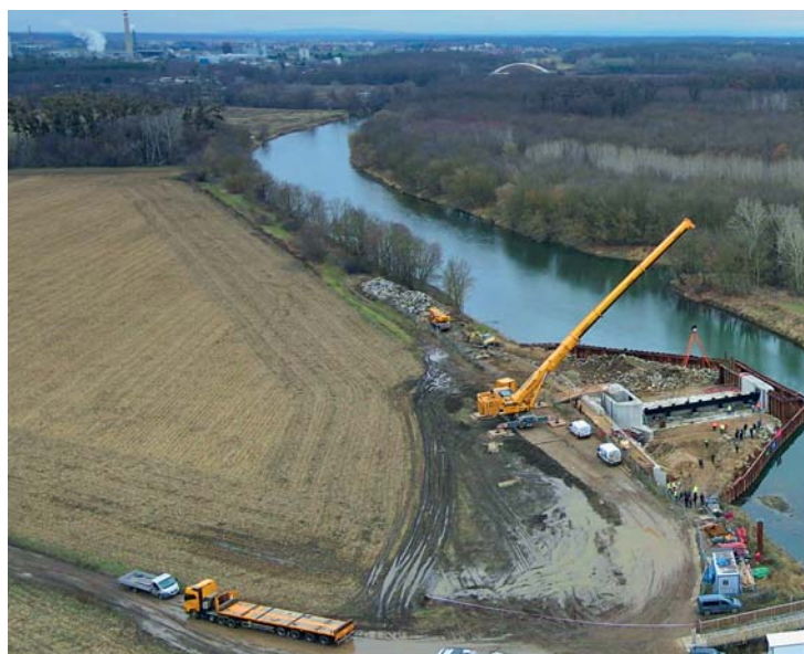
Osazování pravé jezové klapky po dokončení železobetonové konstrukce jezu
