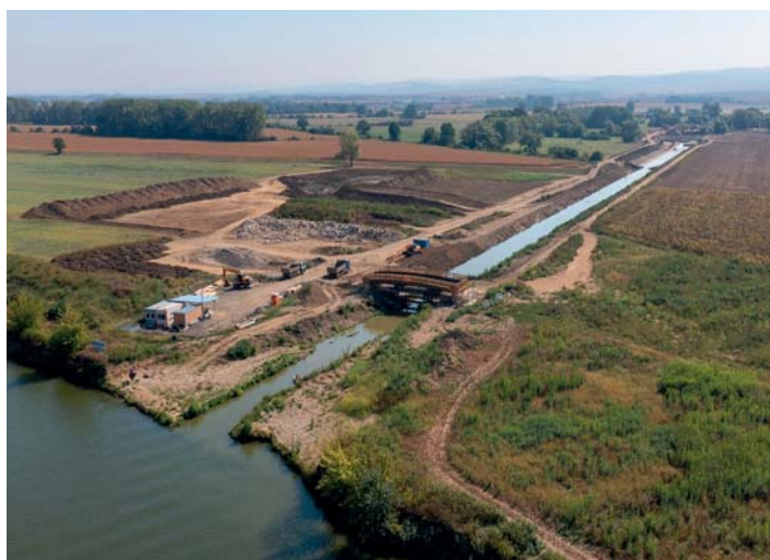
Rozšiřování koryta řeky Radějovky pod PK Rohatec – Sudoměřice – 1. května 2024
