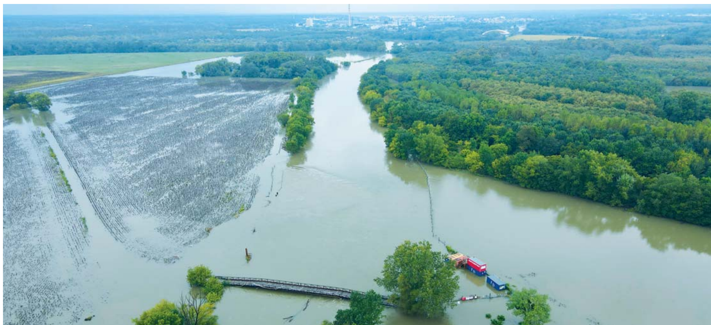
Zaplavená stavba během povodně v září 2024 (ve vodě jen lehce patrný obrys stavební jímky)
