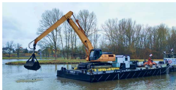
Čištění plavební dráhy Labské vodní cesty
