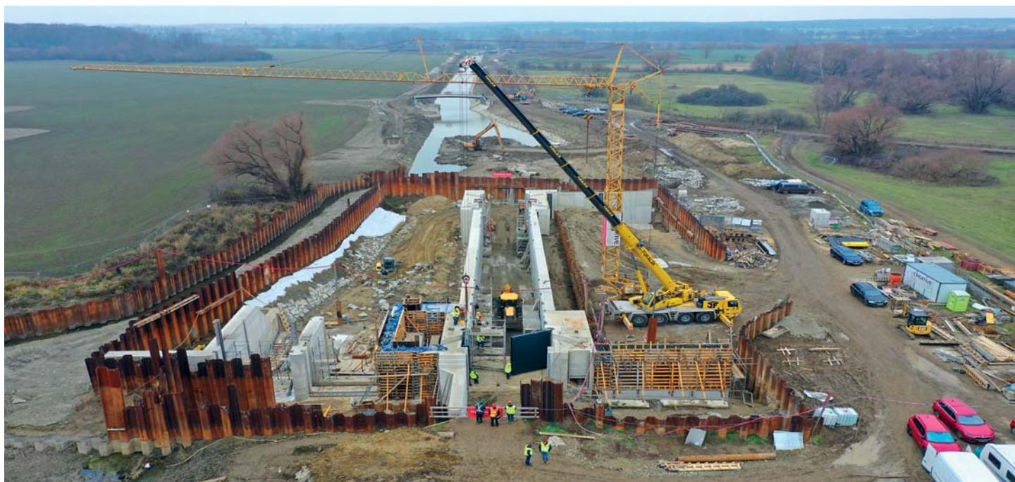
Celkový pohled na staveniště PK Rohatec – Sudoměřice – 3. prosince 2024
