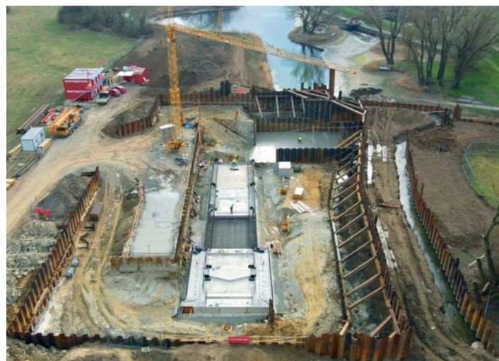
Záběr na stavební jímku z dolní vody (vpravo provizorní přeložky Radějovky do otevřeného kanálu, vpravo nahoře základová deska jezu, uprostřed základové díly PK, nejnižší dolní ohlavi) (zdroj: Metrostav DIZ s.r.o.)
