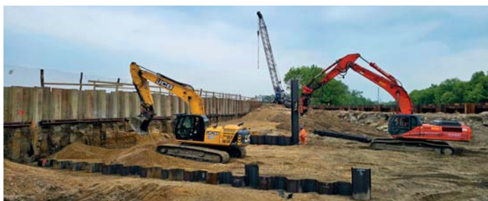
Instalace trvalých štětovnic s cílem zamezit podtékání plánovaného jezu
