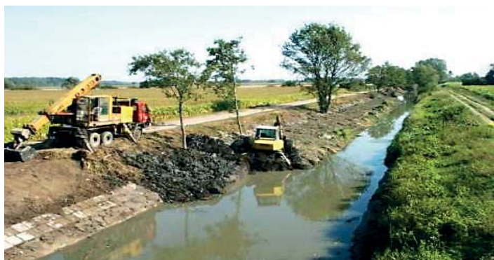
Obnova úseku Petrov – Sudoměřice
