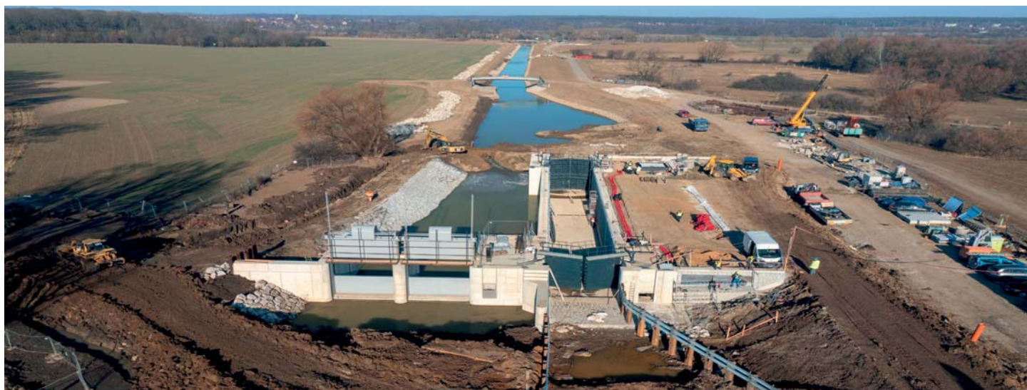
Dokončovací práce na PK Rohatec – Sudoměřice – březen 2025
