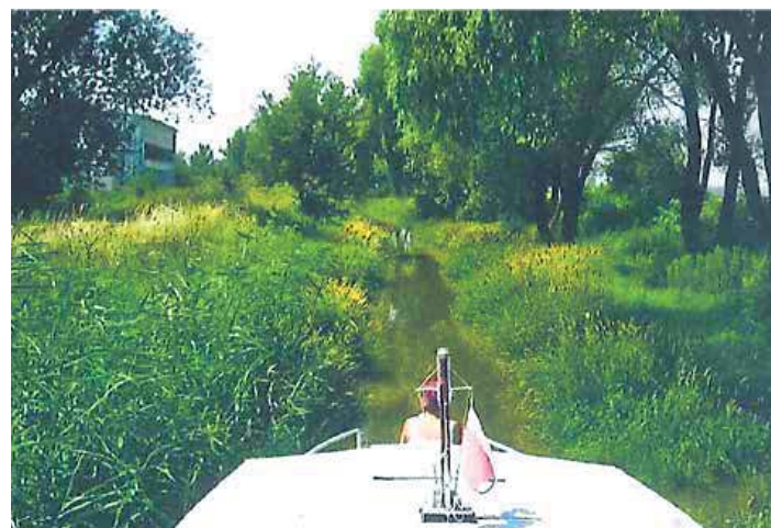
Plavba úsekem Petrov – Sudoměřice před obnovou
