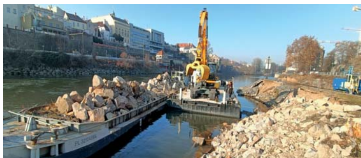
Oprava břehového opevnění Labské vodní cesty v lokalitě Kolín
