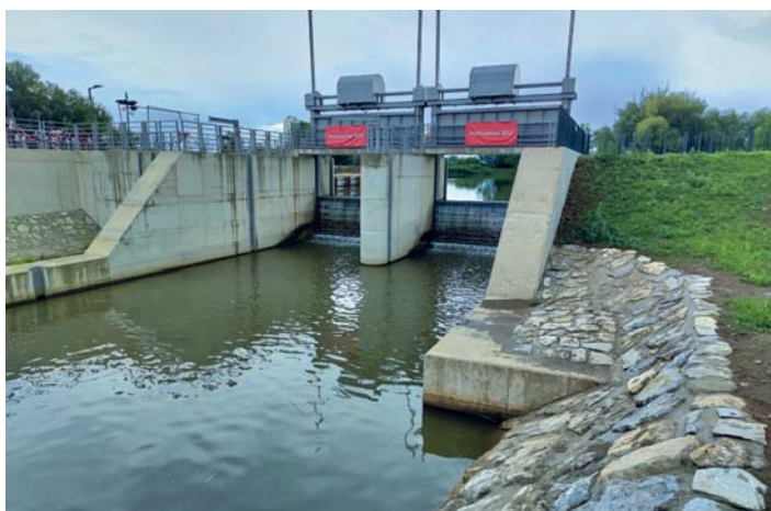
Porovnání stavu před realizací a před dokončením
