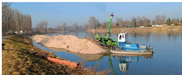
Hloubení dna pomocí podvodního dozeru v lokalitě Čelákovice
