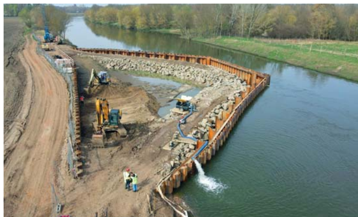
Dokončena jímka, zahájeny zemní práce pro založení jezu
