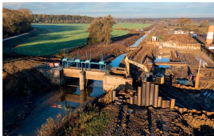
Bourání původního objektu stavidla a stavba základů PK Rohatec – Sudoměřice – říjen 2023
