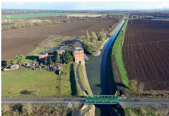
Obnovený Výklopník a Baťův kanál u Sudoměřic
