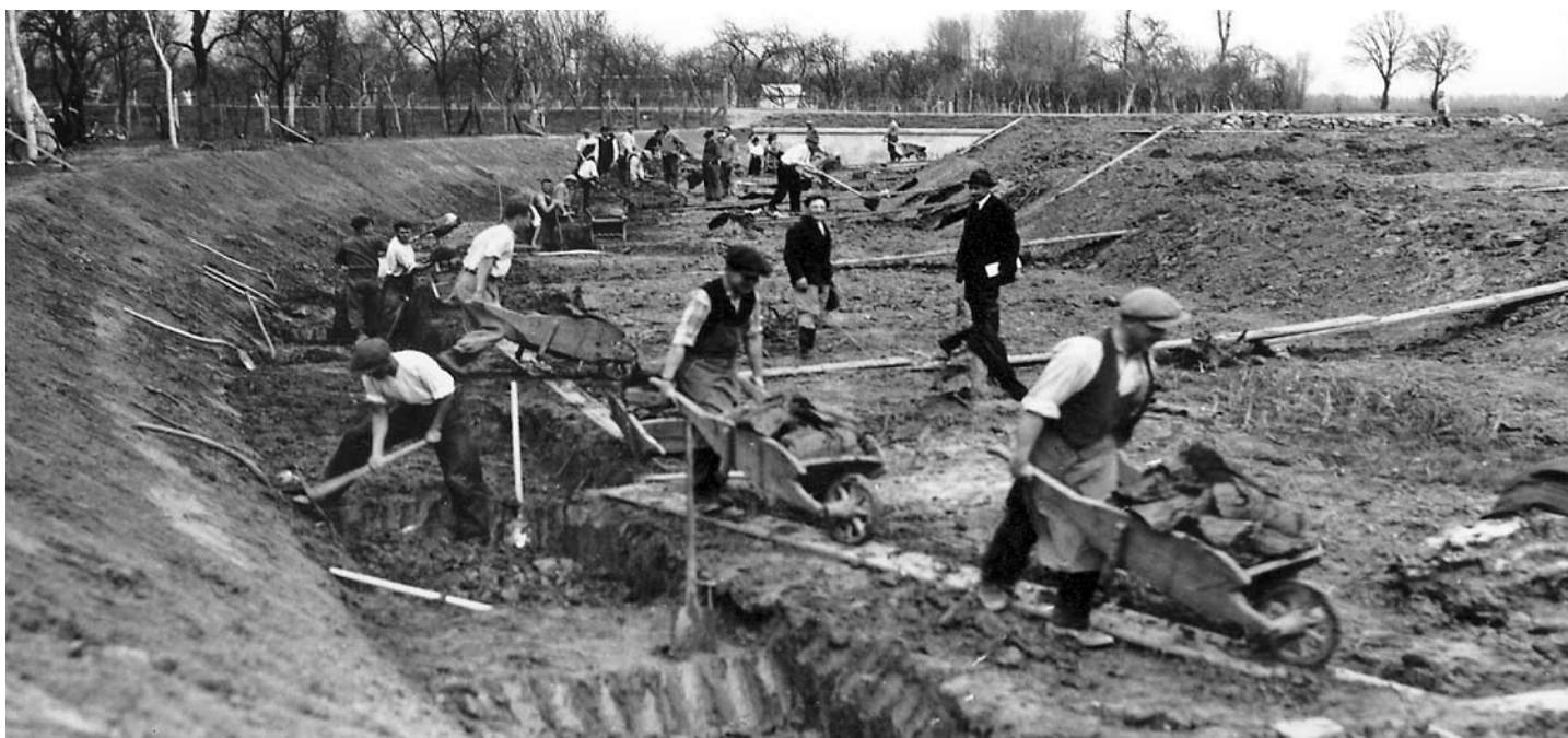
Výstavba Bařova kanálu
