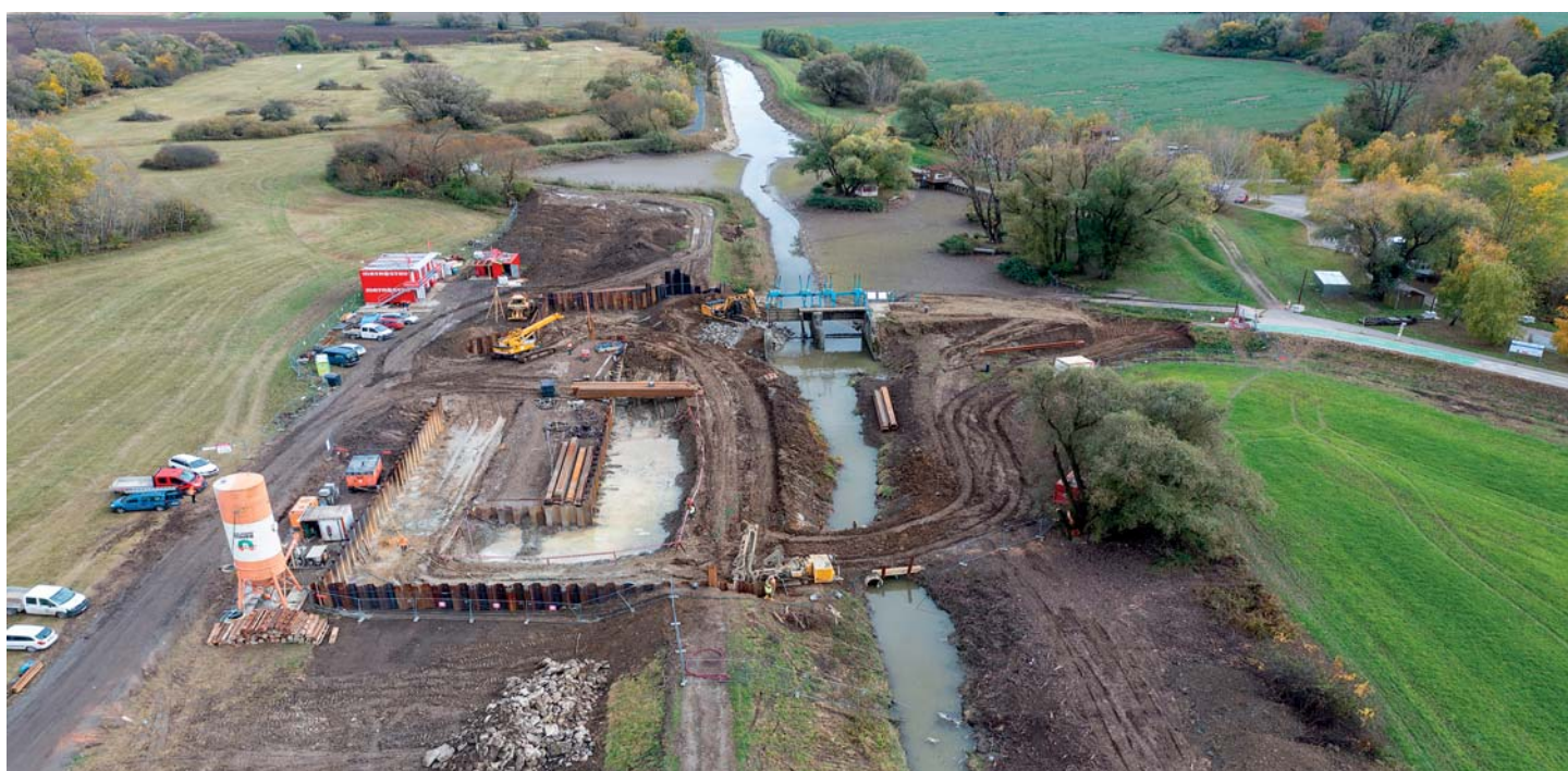
Celkový pohled na staveniště PK Rohatec – Sudoměřice – listopad 2023
