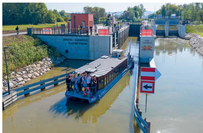
Slavnostní zprovoznění plavební komory Rohatec – Sudoměřice 19. září 2025
