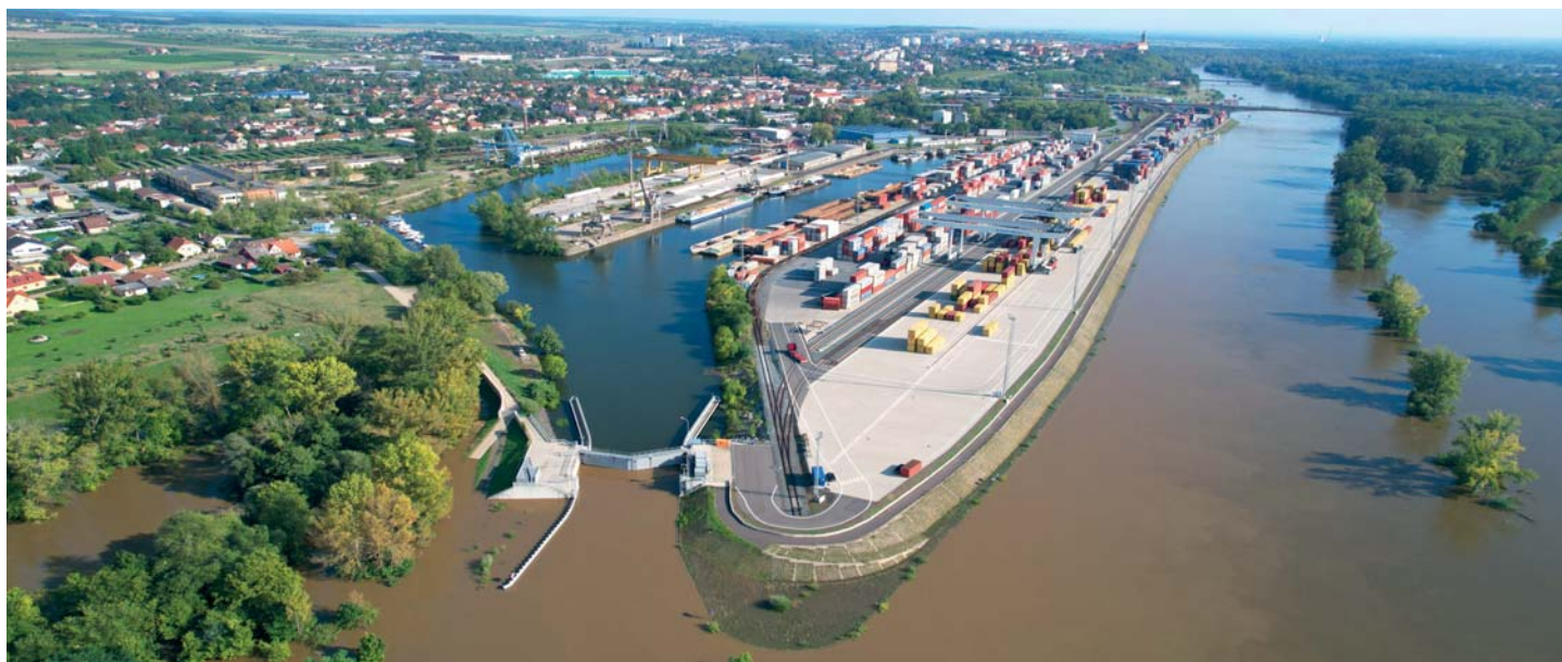
Ochranný přístav Mělník s uzavřenými povodňovými vraty
