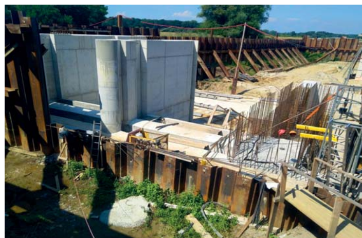
Postup výstavby jezu z horní vody (armování pravého pilíře)
