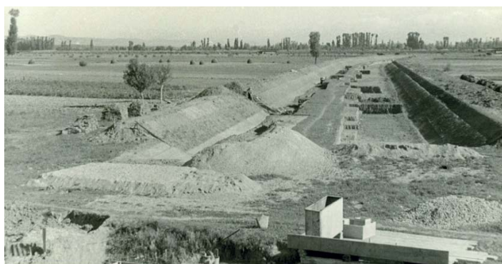
Výstavba Bařova kanálu
