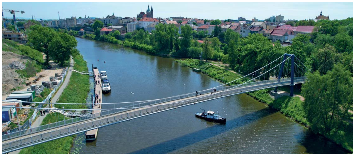
Celkový pohled na nové rekreační přístaviště Kolín
