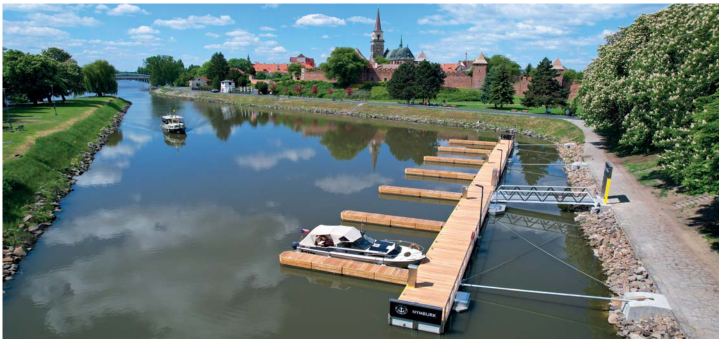
Celkový pohled na nové rekreační přístaviště Nymburk
