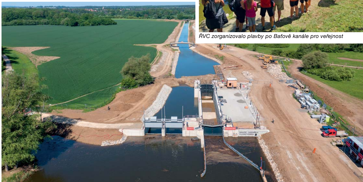
Celkový pohled na plavební komoru Rohatec – Sudoměřice a úpravy řeky Radějovky (červen 2025)
