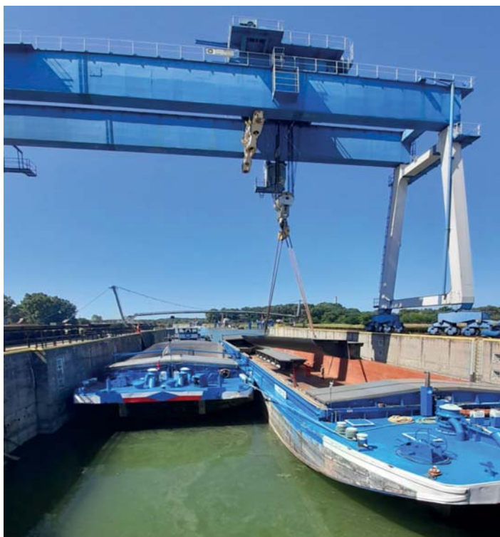
Nakládka mostních konstrukcí v přístavu Bratislava
