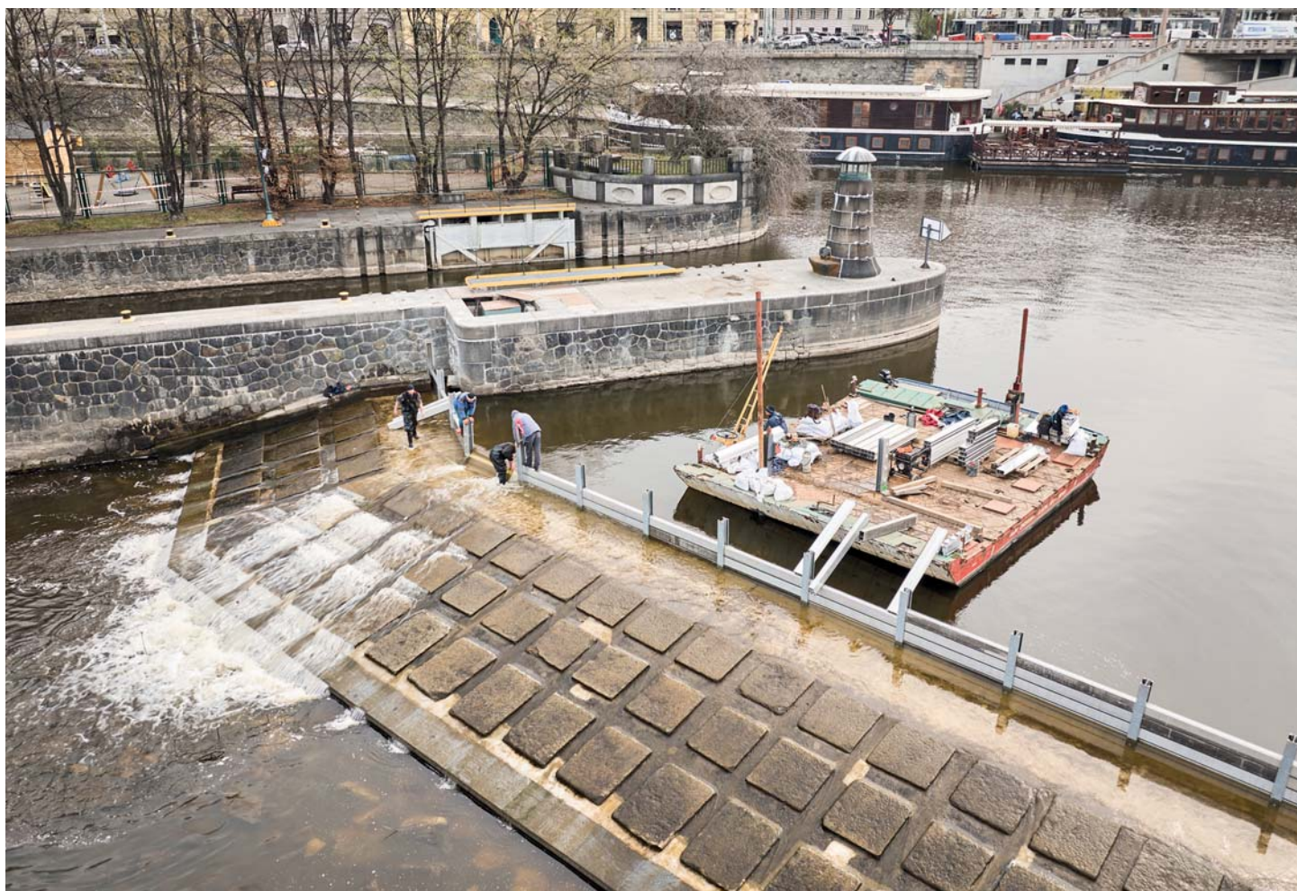
Instalace provizorního hrazení u plavební komory Mánes
