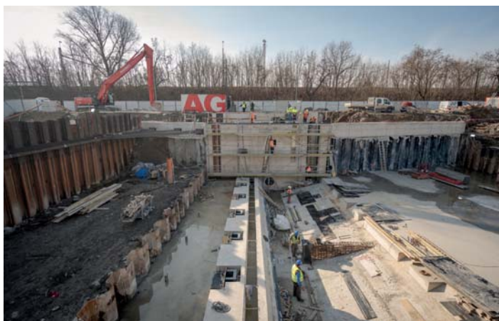
Detail stavební jímky uzávěru (stav březen 2025)
