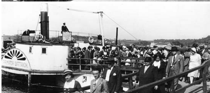
Pražská paroplavební společnost má již od roku 1865 své tradiční přístaviště na dnešním Rašínově nábreží
