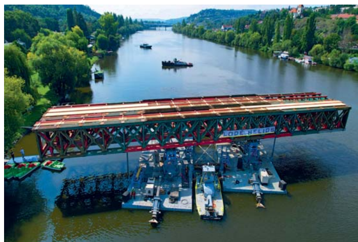
Přeprava nosné konstrukce pro výstavbu Dvoreckého mostu
