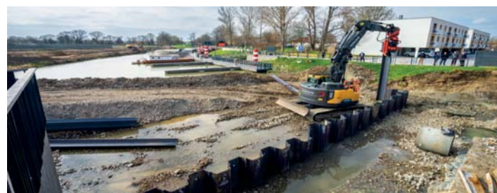
Stavební práce na rozšíření rekreačního přístavu Veselí nad Moravou
