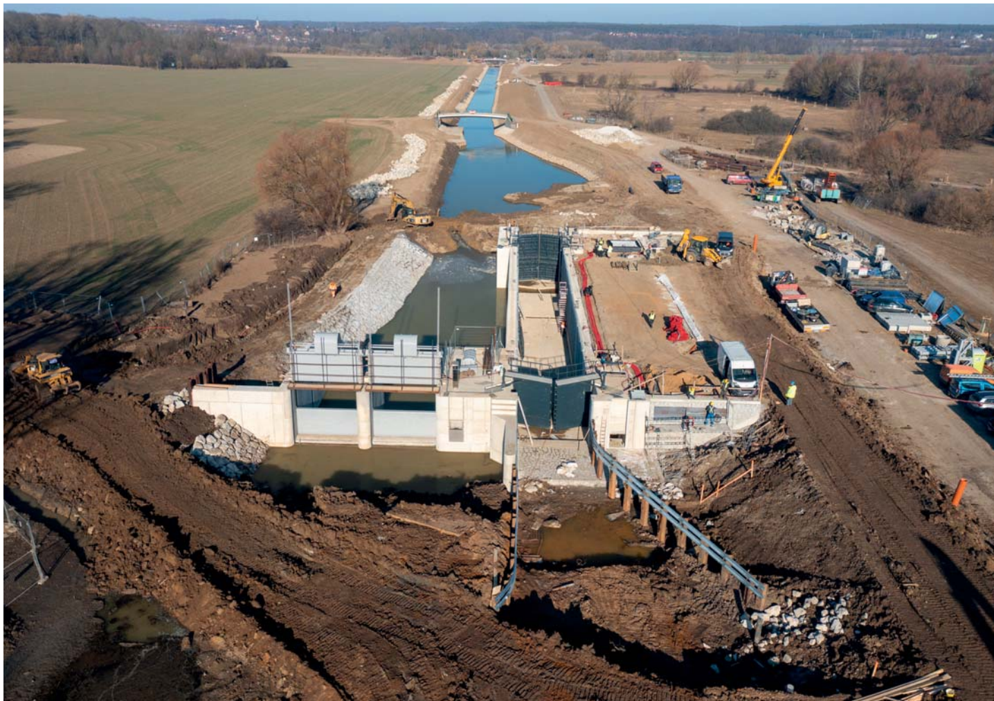
Jez a plavební komora Rohatec – Sudoměřice
