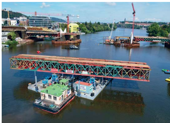
Přesun nosné konstrukce o váze 300 tun pro výstavbu nového Dvoreckého mostu v Praze
