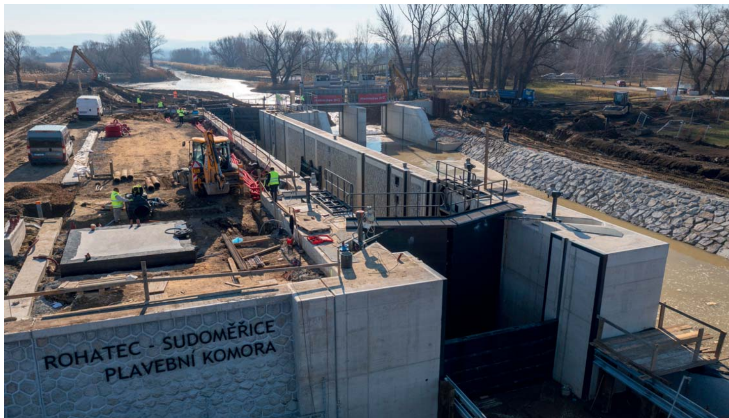
Plavební komora překonává výškový rozdíl 2,7 metru
