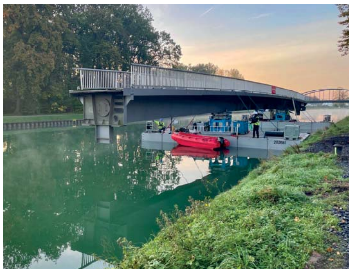
Přeprava lávky pomocí pontonů PMSS ve městě Münster, Německo
