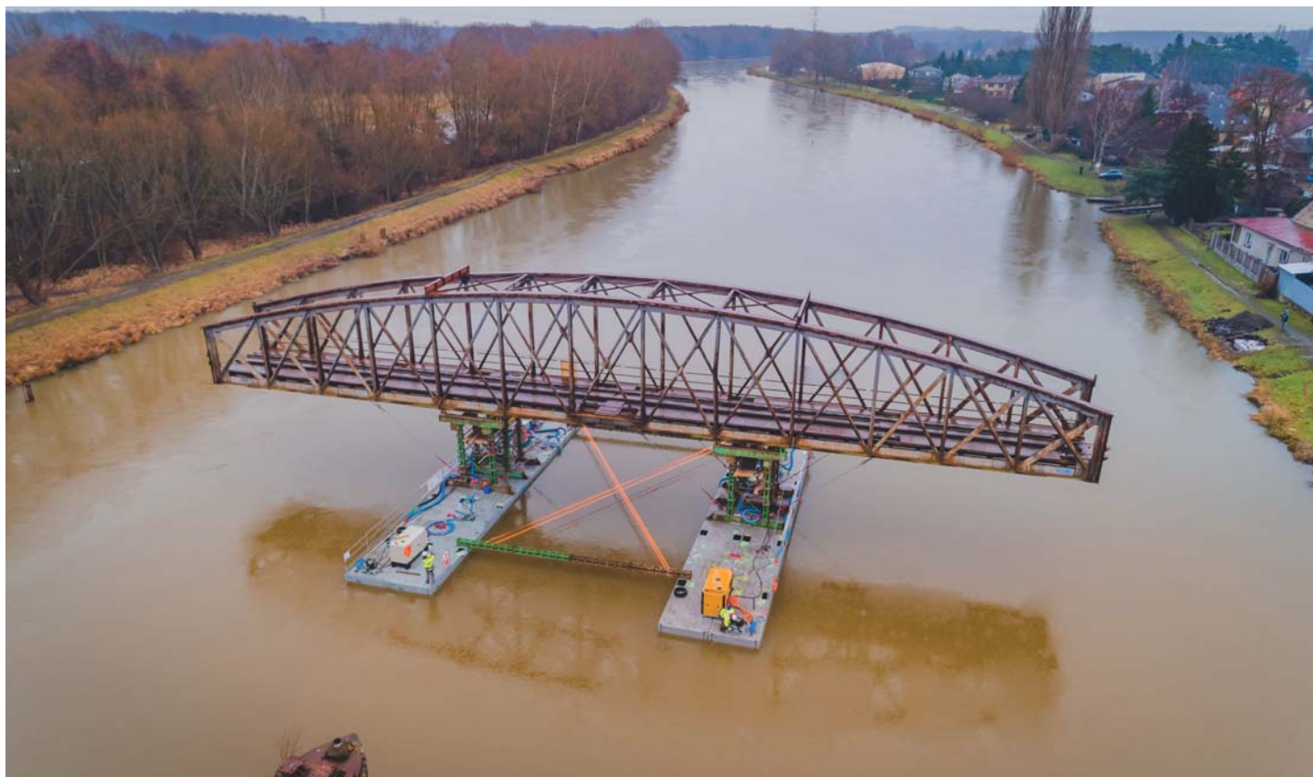
Přesun původních nosných konstrukcí při výstavbě nového železničního mostu v Čelákovících
