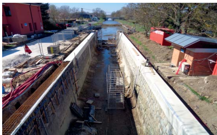
Komplexní oprava plavební komory Veselí nad Moravou
