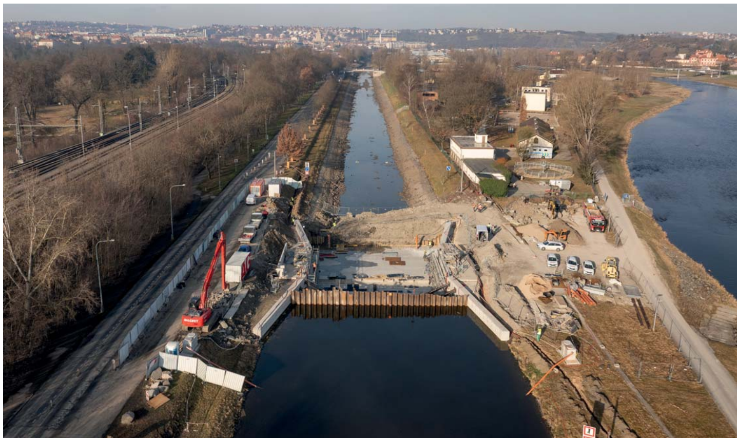
Celkový pohled na staveniště uzávěru plavebního kanálu Troja (stav březen 2025)
