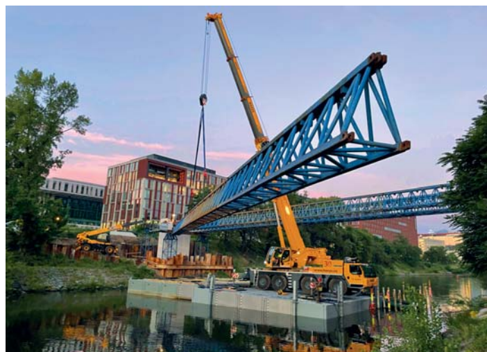
Přeprava mobilního jeřábu na pontonech PMSS s hydraulickými nohami při montáži nosné konstrukce lávky HolKa v Praze
