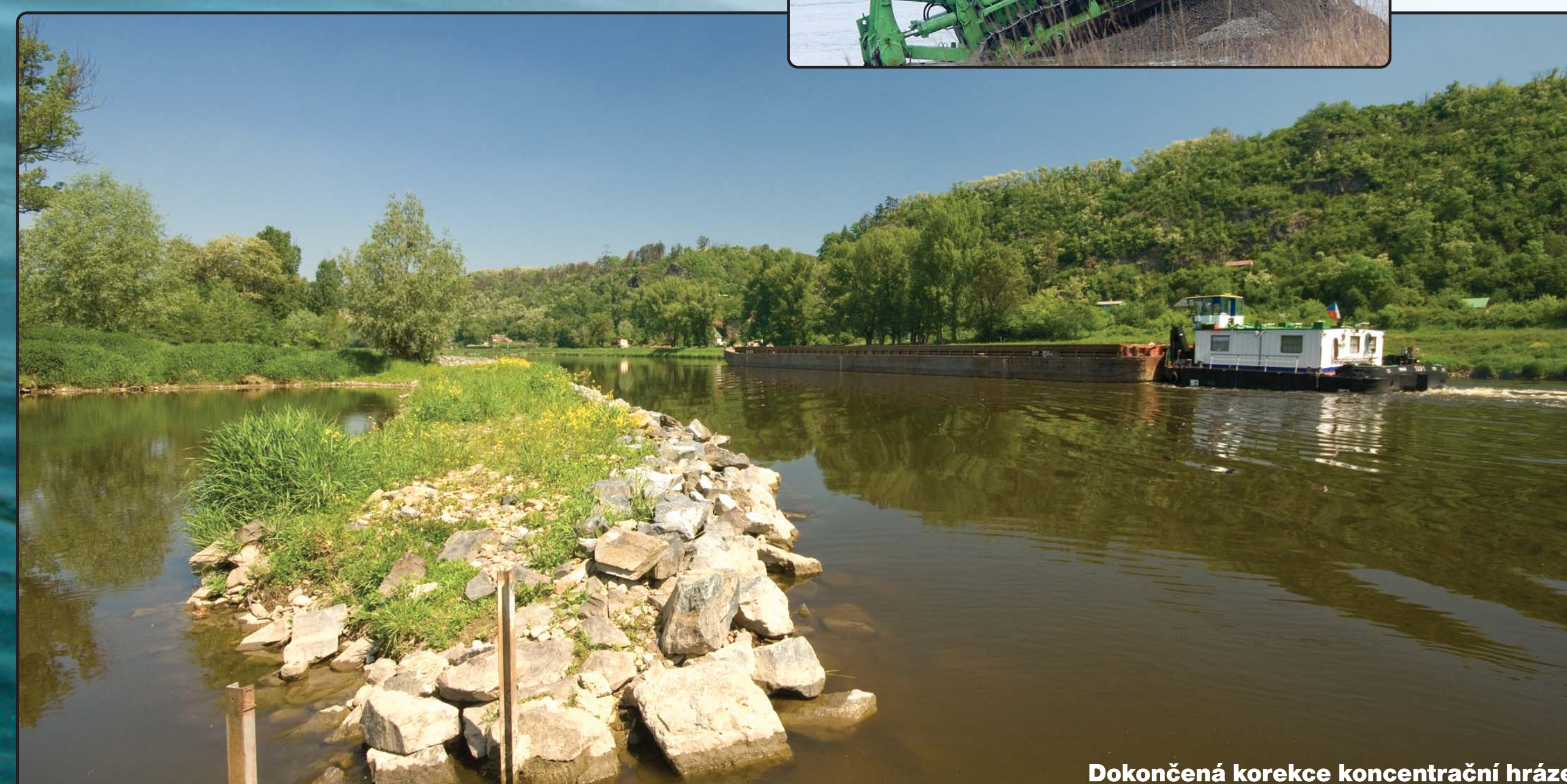
Dokončená korekce koncentrační hráze
