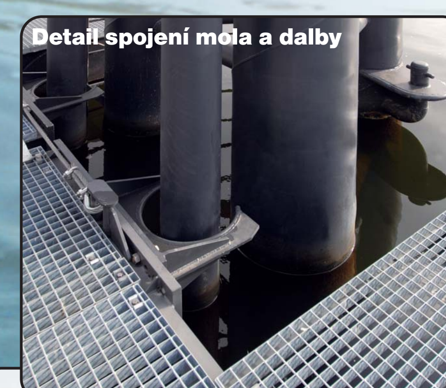
Detail spojení mola a daleb
